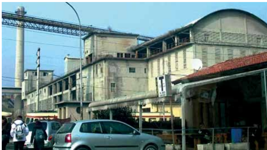
Come si presentava il cementificio Italcementi prima della demolizione
